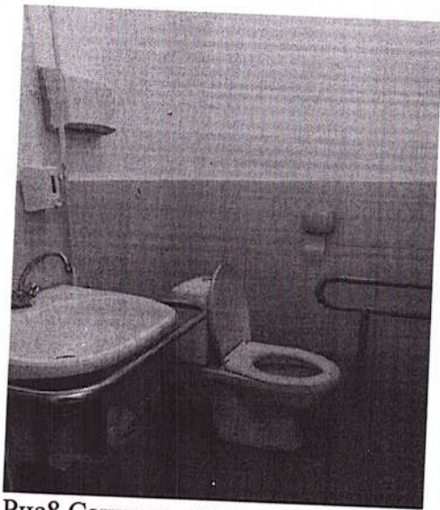
Рис8 Санузел , поручни для унитаза и раковины, накладка на унитаз с поручнем
