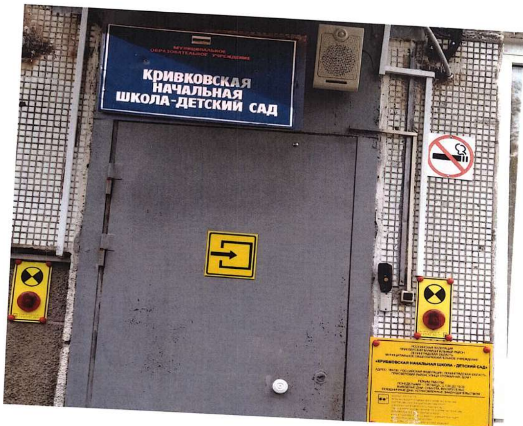
Рис2 вход №1 Входная дверь с табличкой «вход в помещение», кнопка вызова, звуковой оповещатель, вывеска со шрифтом Брайля
